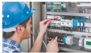
Kontrolle der Installationen
