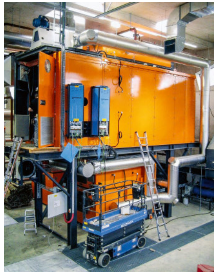
Die Wärme-Kraft-Kopplungsanlage mit Heissluftturbine in der Energiezentrale der Fernwärme Düdingen.
