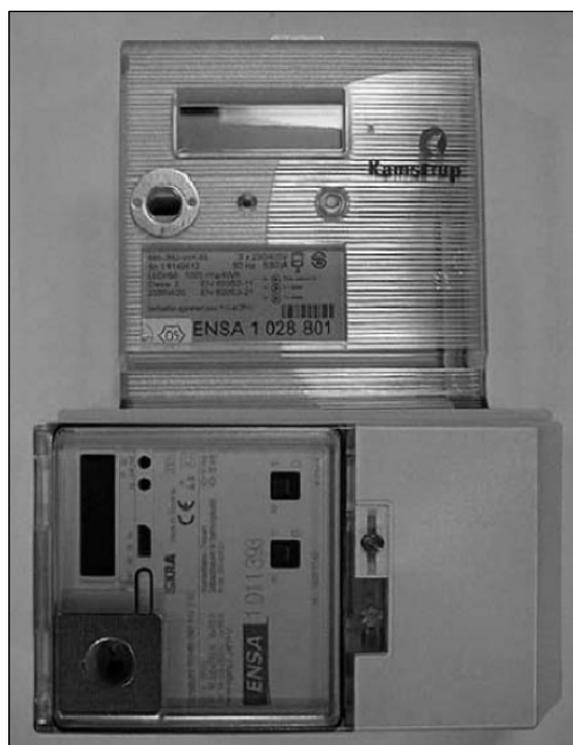
Montage eines Fernsteuerungsempfängers oder einer Schaltuhr auf einem Zähler
