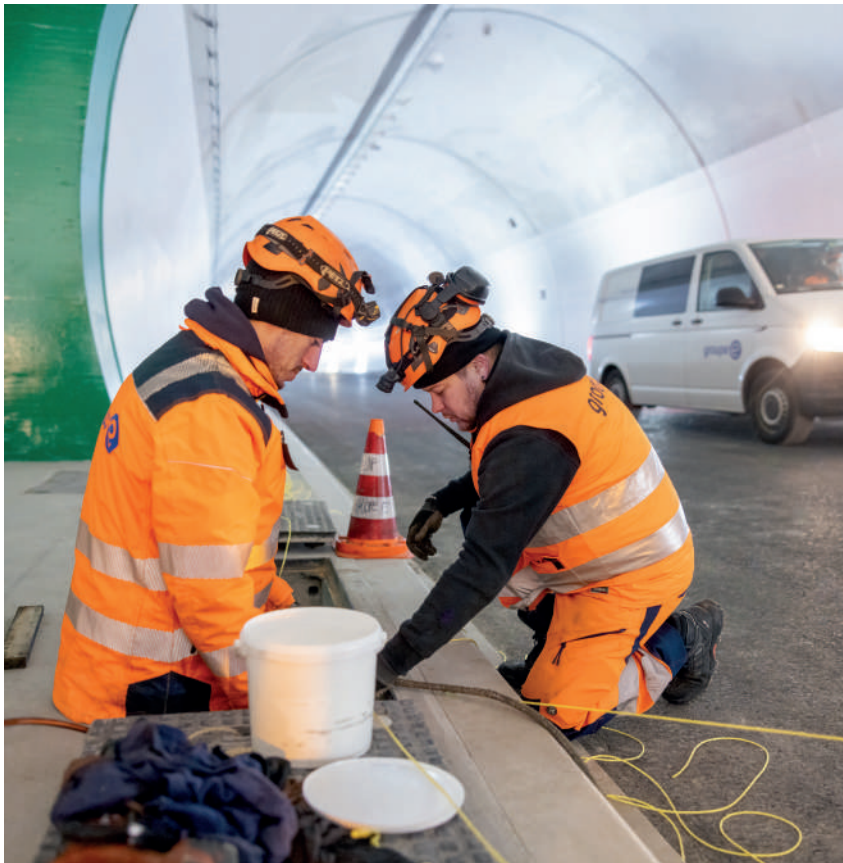
Les expert·e·s des installations techniques construisent et rénovent également les infrastructures routières et ferroviaires.
