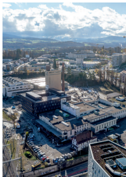
Le contracting permet aux entreprises et collectivités publiques d'accéder à des flux d'énergie et d'en déléguer la gestion et l'exploitation à Groupe E, comme ici à bluefactory.
