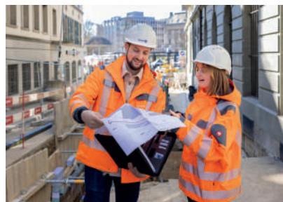
Le CAD Fribourg continue son expansion avec 6 km de conduites posées en 2024.
