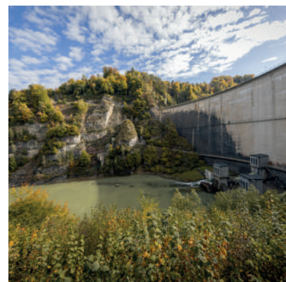
En 2024, 83,8% de l'électricité produite par Groupe E provient de l'énergie hydraulique.
