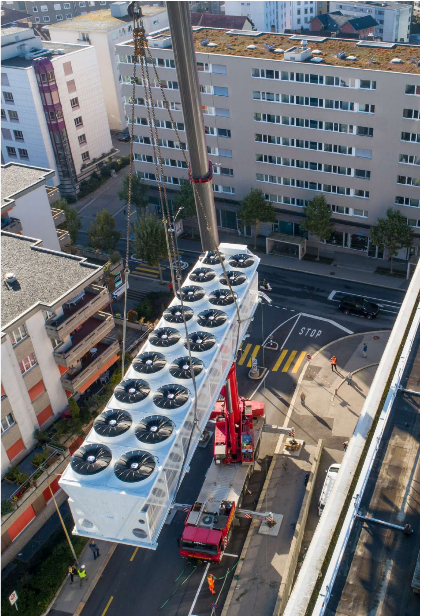
Livraison d'une pompe à chaleur E-PAC.
