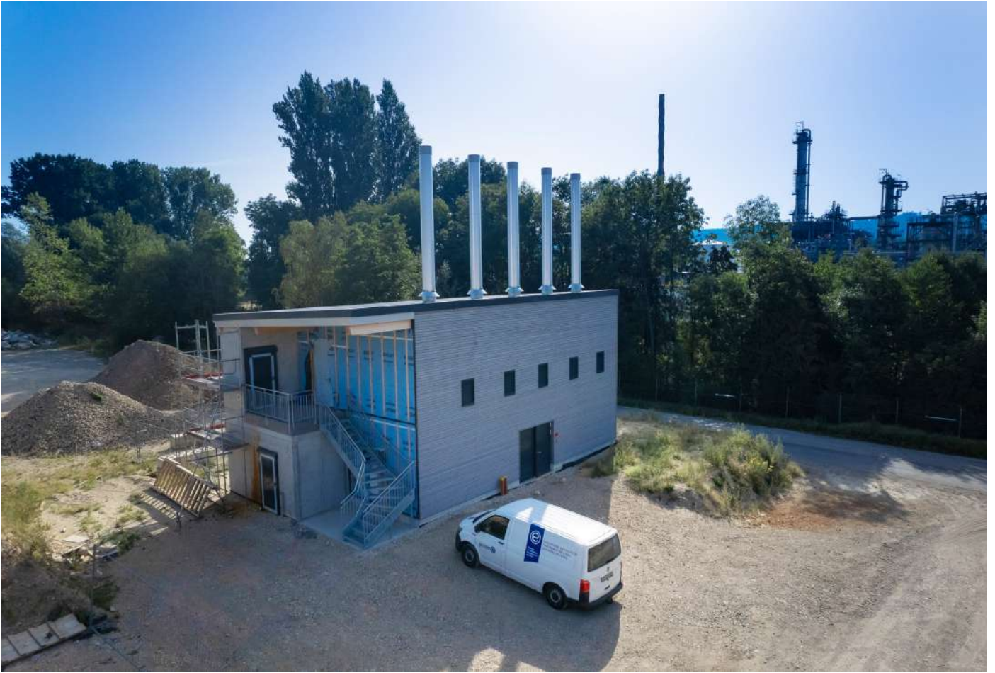
Centrale de secours du CAD Entre-deux-Lacs.
