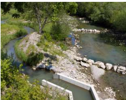
Le nouveau ruisseau de contournement de la Jogne, à l'aval de la centrale hydroélectrique de Broc.
