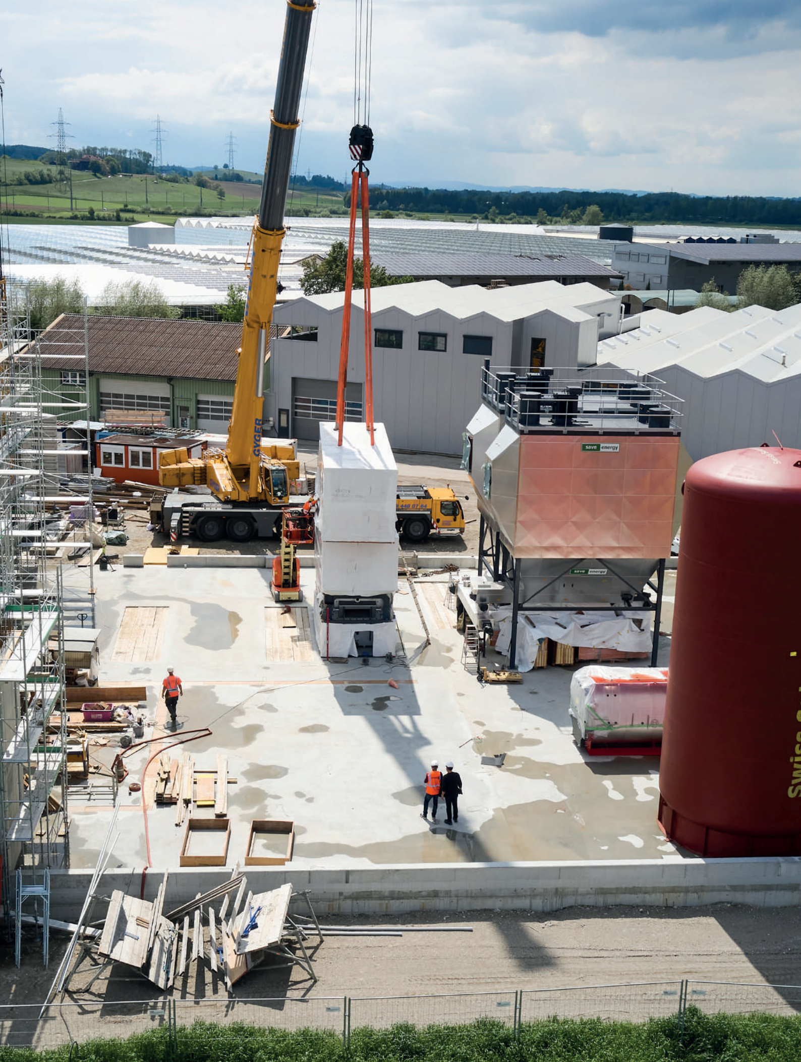
Installation des chaudières dans la future centrale de chauffage de Chiètres
