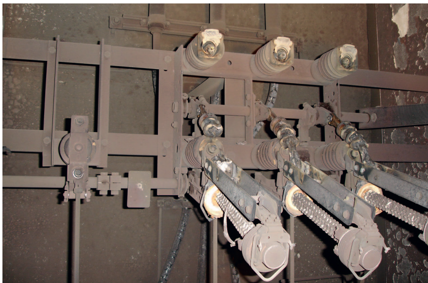
Les conséquences d'un manque d'entretien peuvent être désastreuses; installation moyenne tension détruite.
