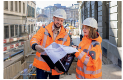
Die Fernheizung Freiburg wird ausgebaut. 2024 wurden mehr als 6 km Leitungen verlegt.
