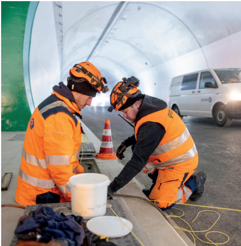
Die Expertinnen und Experten für technische Anlagen bauen und sanieren auch Strassen- und Schieneninfrastruktur.
